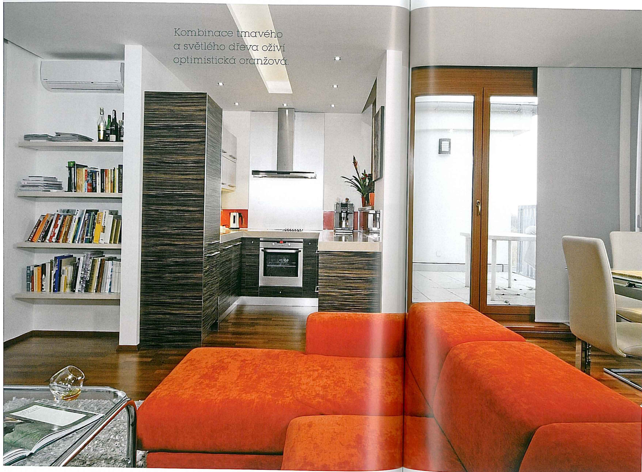
Zářivky jsou vloženy do kapsy v sádkartonovém podhledu.
